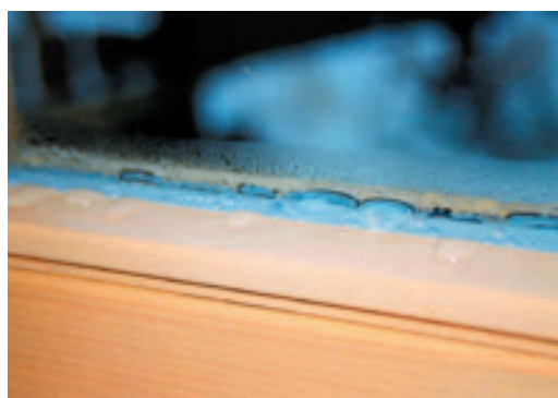
Abb 41 | Kondenswasser im Randbereich des Fensters
