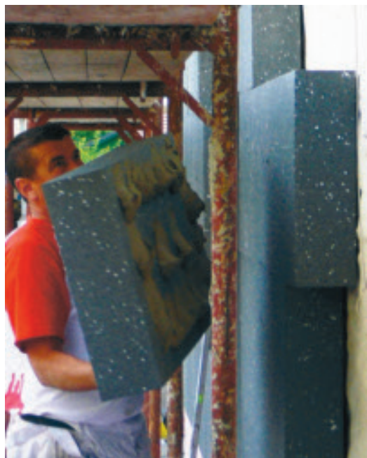
Abb 29 | Kleberauftrag: Damit sich die Dämmplatten nicht nach einiger Zeit wölben und die Dämmung hinterströmt wird (Matratzeneffekt), muss der Kleber nach der Punkt-Wulst-Methode aufgebracht werden.
