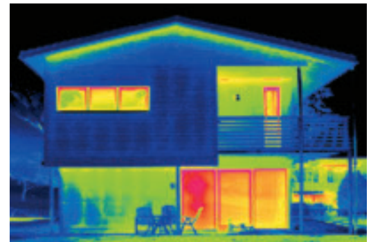
Abb 22 | Mit Thermografieaufnahmen werden Schwachstellen sichtbar gemacht.
