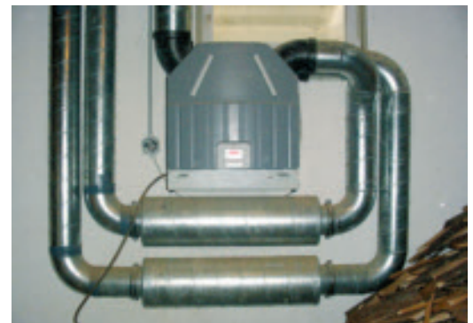
Abb 58 | Lüftungsgerät mit Wärmetauscher
