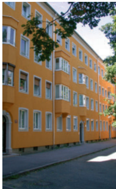
Abb 17 | Der Fassadendämmung und dem Fenstertausch folgt die thermische Sanierung von Dach, Boden und Keller.
