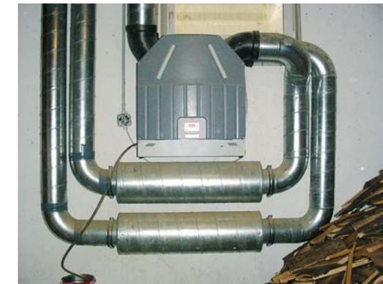
Abb. 44 | Lüftungsgerät mit Wärmetauscher und Schalldämpfer
