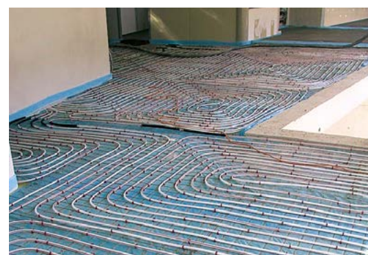
Abb. 28 | Fußbodenheizung
