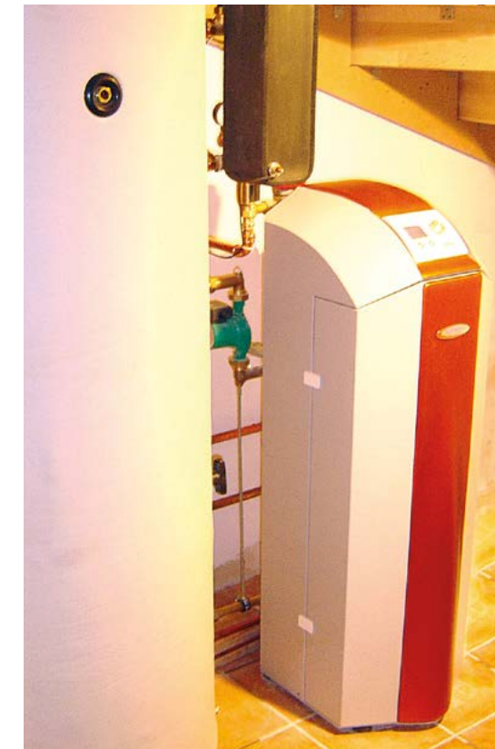
Abb. 31 | Wärmepumpe
